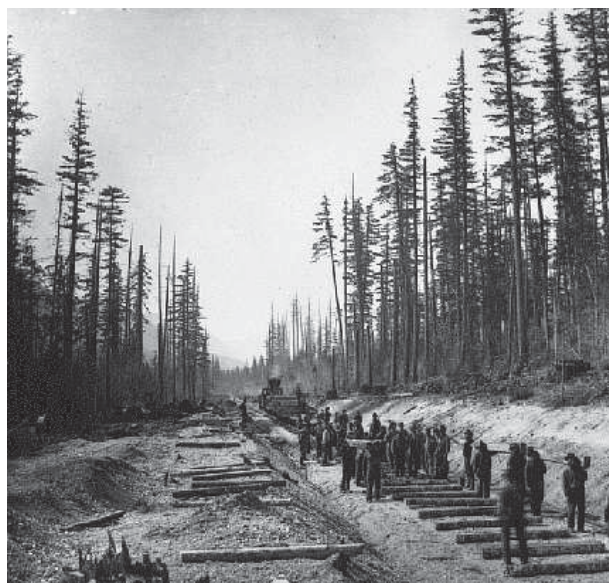
Ouvriers travaillant sur la dernière section du Canadien Pacifique
