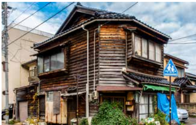
Maison abandonnée à Kanazawa, dans la préfecture d'Ishikawa, au Japon.
